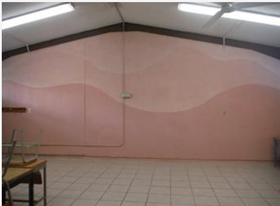
Figura 3. Muro con aplicación de color, resultado final.
