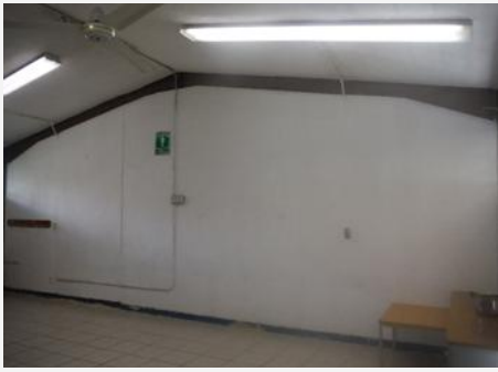
Figura 1. Muro antes de la aplicación de color.
