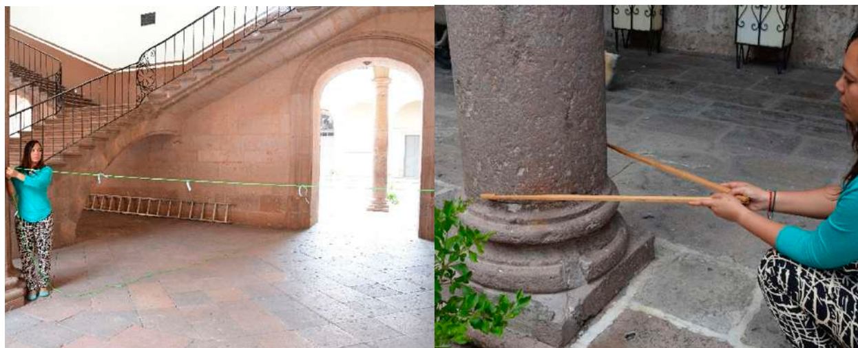
Figura 13. Medición del fuste con el compás y revisión de medidas por medio de cinta seccionada en varas castellanas. Fotos: Archivo Torres Salomao, 2017.
