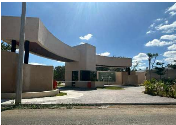
Figura 3. Límites habitacionales. Segregación habitacional voluntaria, ejemplo: Residencial en Conkal.
