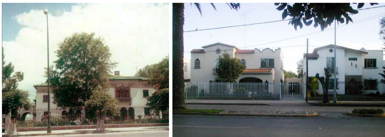
Figura 3. Casas que se demolieron en Av. V. Carranza, la primera y las que le siguieron
