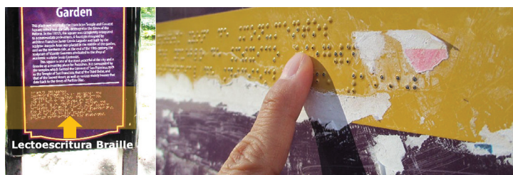
Imagen 4. Señalética accesible e inclusiva en mal estado, centro histórico, S.L.P., Fuente: el autor 2020.
