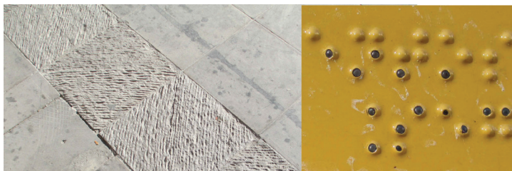
Imagen 2. Acciones que se realizan en el espacio para hacerlo más accesible. Piso táctil para invidentes y lectoescritura en sistema braille, centro histórico, S.L.P., Fuente: el autor 2020.
