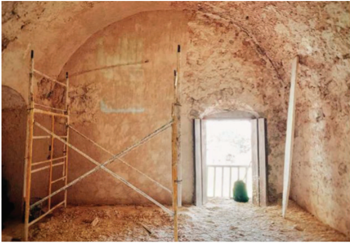
Imagen 2 Aplicación de mortero con agua de chukum en muros y bovedas, Pacheco, P. (2019)
